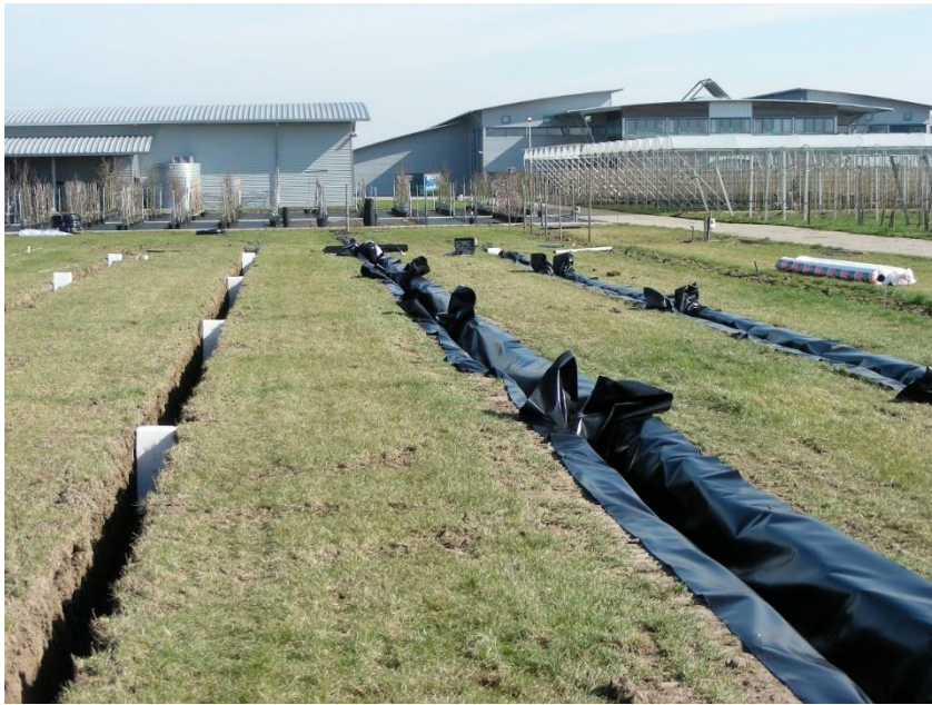
Aanleg van de sleuvenproef in 2011 met 48 veldjes van 10 meter lang.
